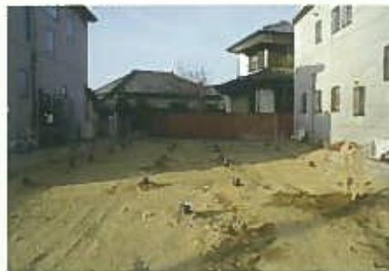
くい打設後もきれいな現場
