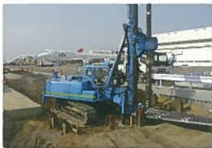
大型工事も安心施工
